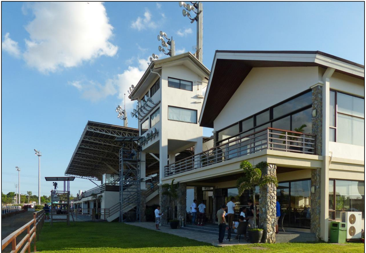
Blick aus der anderen Richtung, rechts das VIP-Gebäude, daneben der Zielrichterurm.
