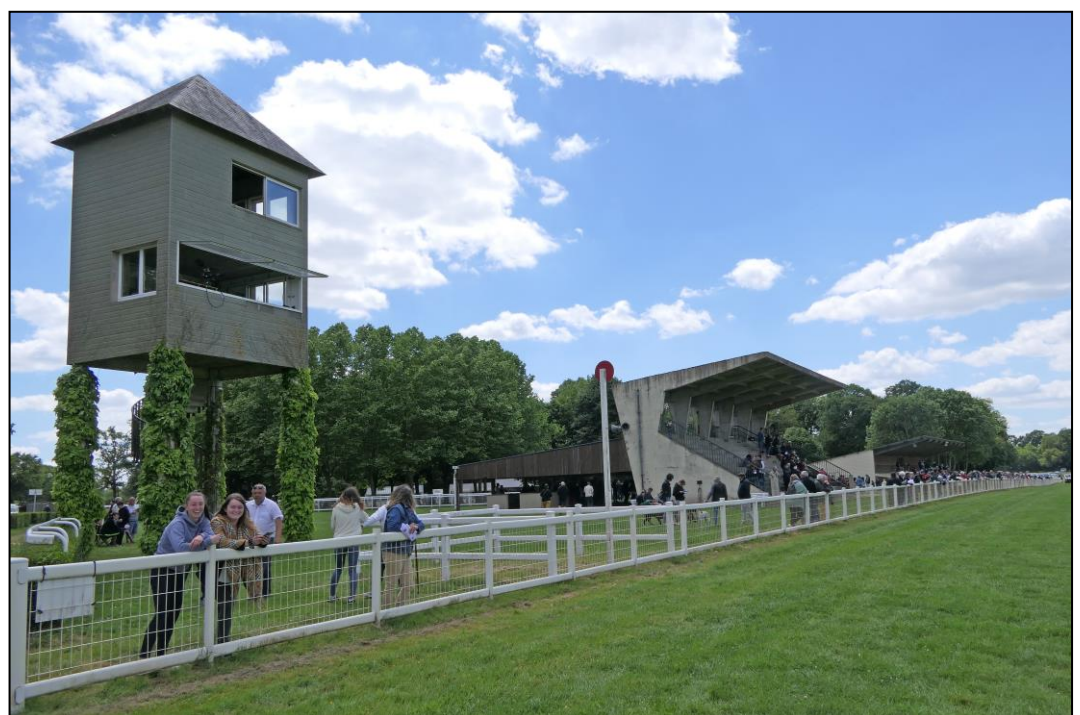
..... Richterturm und den beiden Tribünen.
