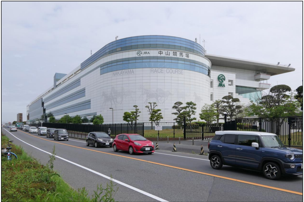
Tribüne von der Straßenseite aus
