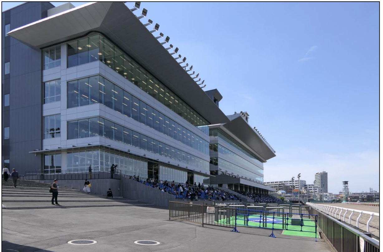
Die beiden Tribünen, verglast und natürlich mit Rolltreppen und Klimaanlage
