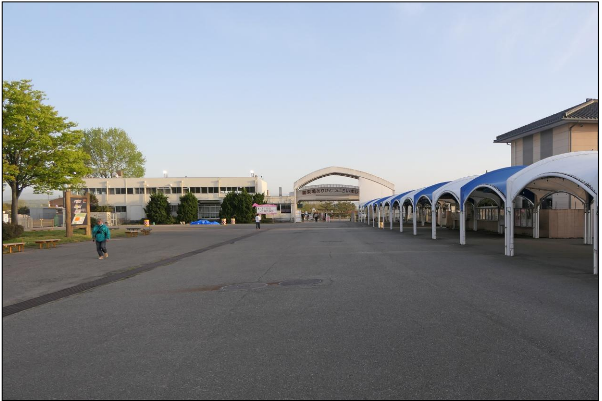
Auch hier gibt es einen überdachten Fußweg vom Eingang zur Tribüne.
